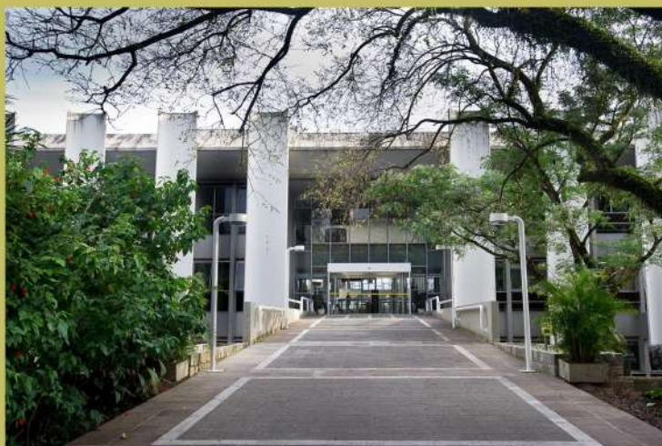
A rampa na entrada principal da Câmara Municipal de Porto Alegre.
